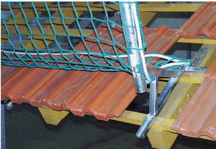
Mit der Dach- Absturzsicherung kann schnell und einfach eine Absturzsicherung auf dem Schrägdach erstellt werden. Die Dach-Absturzsicherung ist auch als zusätzliche Zwischenschutzwand geeignet.
