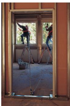
Türtraverse nach EN 795. Maximale Öffnungsbreite: 124 cm, für 2 Benutzer geeignet.
