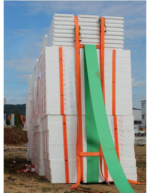
Isolations-Hebegurte mit Ausrutschsicherung beim Anheben. Inklusiv UR3511/25m und 15 Steg­schlaufen an Hebegurt.
